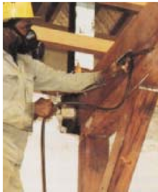
Outre les termites souterrains, des termites dits de bois sec sévissent dans les DOM. Leurs colonies sont entièrement localisées dans le bois, sans contact avec le sol. Les traitements classiques sont inefficaces contre eux.
